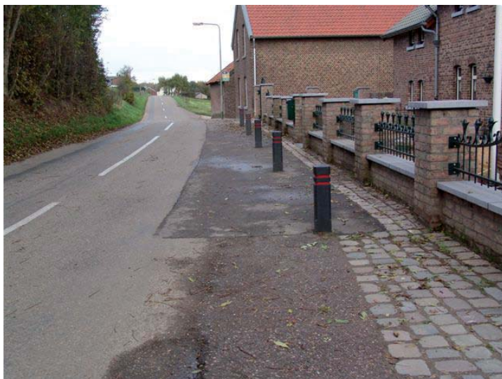
Foto2 – De in 2005 gerealiseerde situatie bij Slenakerweg 15. Op de foto is de nieuwe asfaltuitvulling bij de paaltjes duidelijk te zien, onderaan de foto de rechtersproeg met daartegenaan de oude asfaltuitvulling die enkele jaren eerder is aangebracht.
