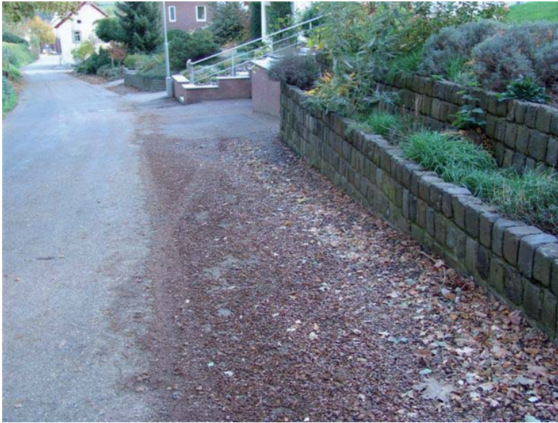
Foto 3 – Een voorbeeld van asfaltafwerking in de gemeenteberm op de Eyserbosweg te Eys. De percelen liggen net als op de Slenakerweg niet in rechte lijn. De berm is bij uitvullingen van de weg meegeasfalteerd. Het asfalt (hier deels bedekt door bladeren) ligt tot aan de tuinmuur. De positie van de lantarenpaal, waarvan er ook een achter de fotograaf staat doet vermoeden dat in deze berm naast nutsleidingen ook een leiding moet liggen voor de verlichting
